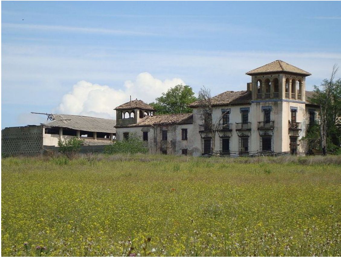
Ilustración 3. La Casería de Los Cipreses situada en el PN-3 de Granada en un deplorable estado de conservación. Fotografía tomada en mayo de 2012.
